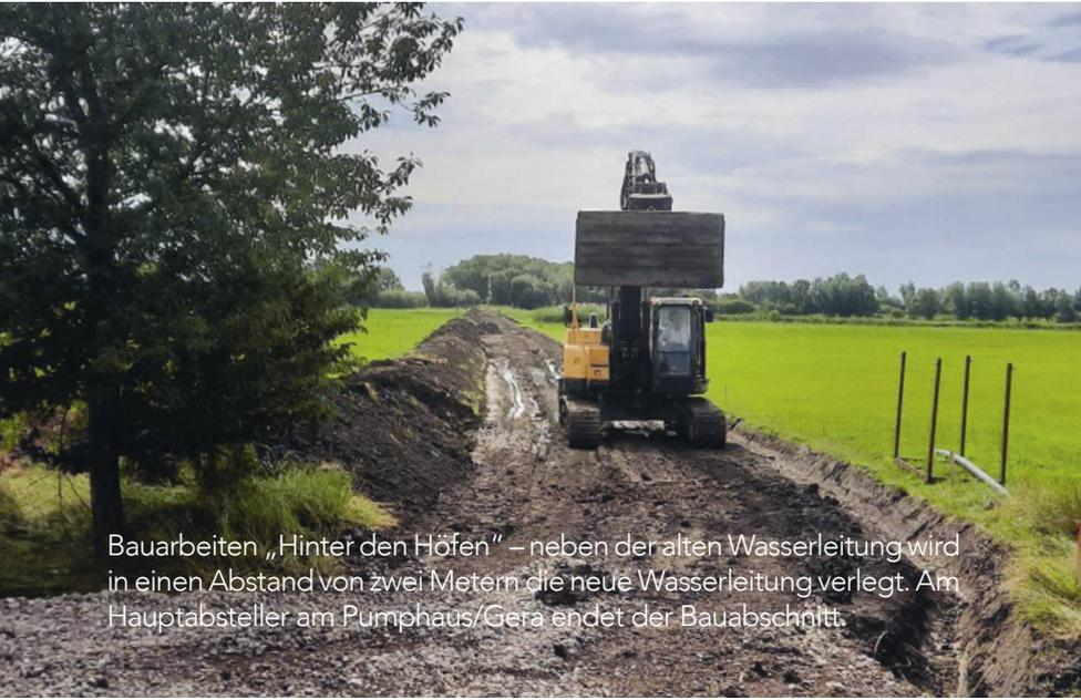
Bauarbeiten „Hinter den Höfen“ – neben der alten Wasserleitung wird in einen Abstand von zwei Metern die neue Wasserleitung verlegt. Am Hauptabsteller am Pumphaus/Gera endet der Bauabschnitt.
